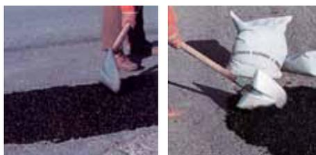
Conglomerato bituminoso di altissima qualità, utilizzabile in qualsiasi condizione stagionale ed applicabile anche su superfici bagnate. Prodotto di eccezionale lavorabilità ed elevatissime caratteristiche di resistenza al traffico pesante
