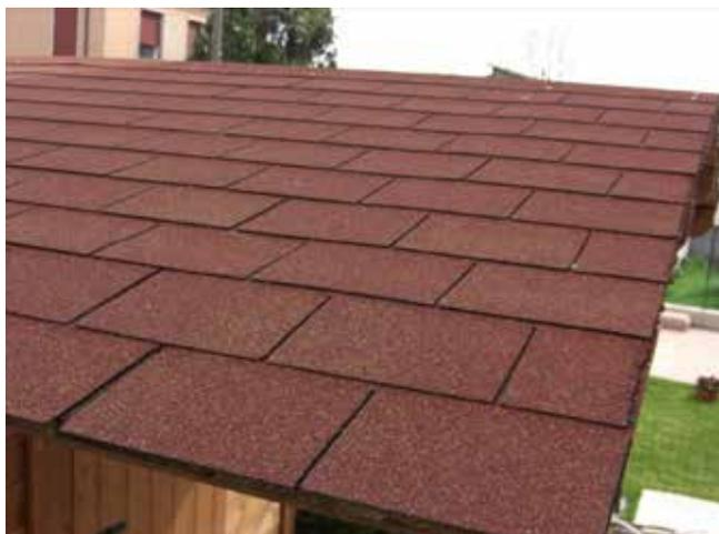
La superficie del tetto preventivamente trattata con prodotti contro l'umidità, deve essere liscia, solida, asciutta e ben fissata. Utilizzare un compensato di buona qualità, pannelli di legno per rivestimento o piastre da costruzione in legno non impiallacciato.
